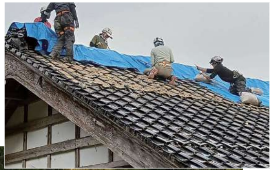
クライミングをいかに発揮した屋根上の作業
