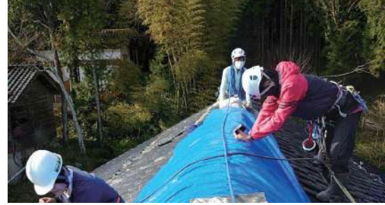
屋根の雨漏り応急処置作業
