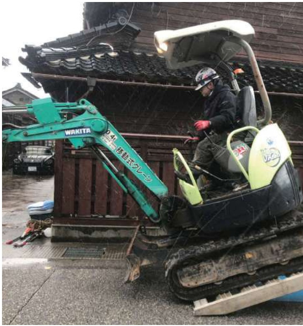
建機クレーンを使った撤去作業
